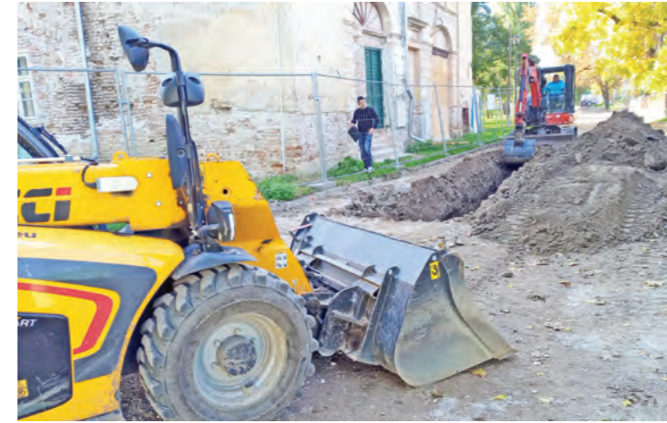
Aktuálne sa pracuje na prípojkách vody, kanalizácie a plynu. foto: zs
